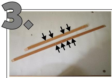
Hier bringst Du die Schrauben an. Von der jeweiligen Mitte der Außenbögen links und rechts zwei Stück. Bohre die mittenliegenden Holzbögen mit dem 2mm-Bohrer vor (am Besten die Bogenteile übereinander legen und durch die vorhandenen Löcher durchbohren)
