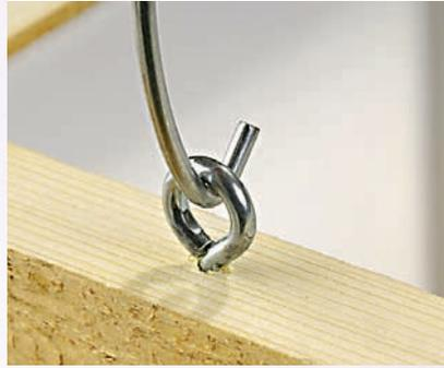
8.) Er sollte in die parallel angeordneten Schraubösen unter Spannung eingesetzt werden
